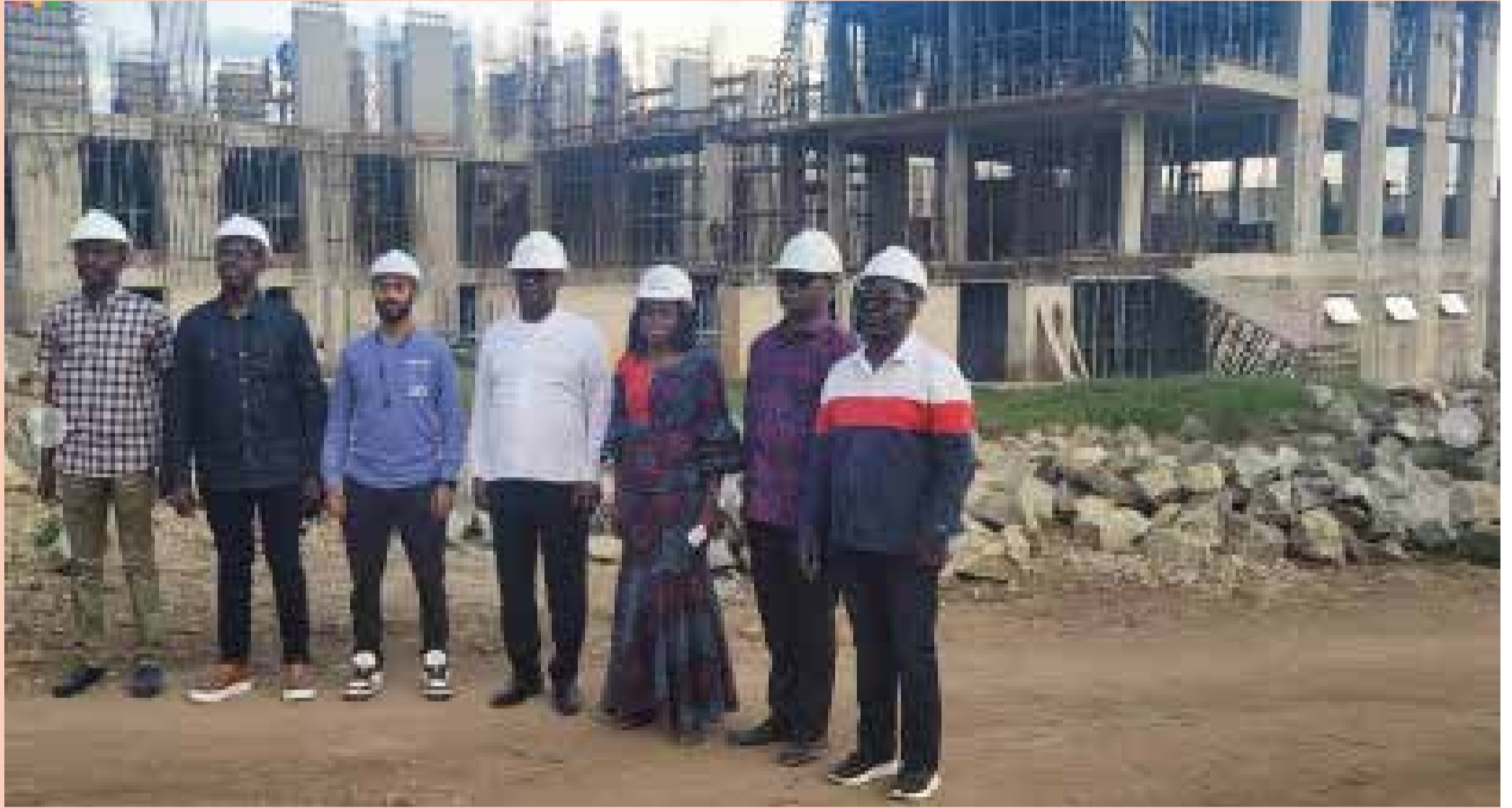
À Bunia, impressionné par les récits des bâtiments en construction de l'Université, le Prof. Tryphon Kin-kiey Mulumba demande au Gouverneur militaire à les visiter avant d'immortaliser son passage avec les membres de sa délégation. DR.
